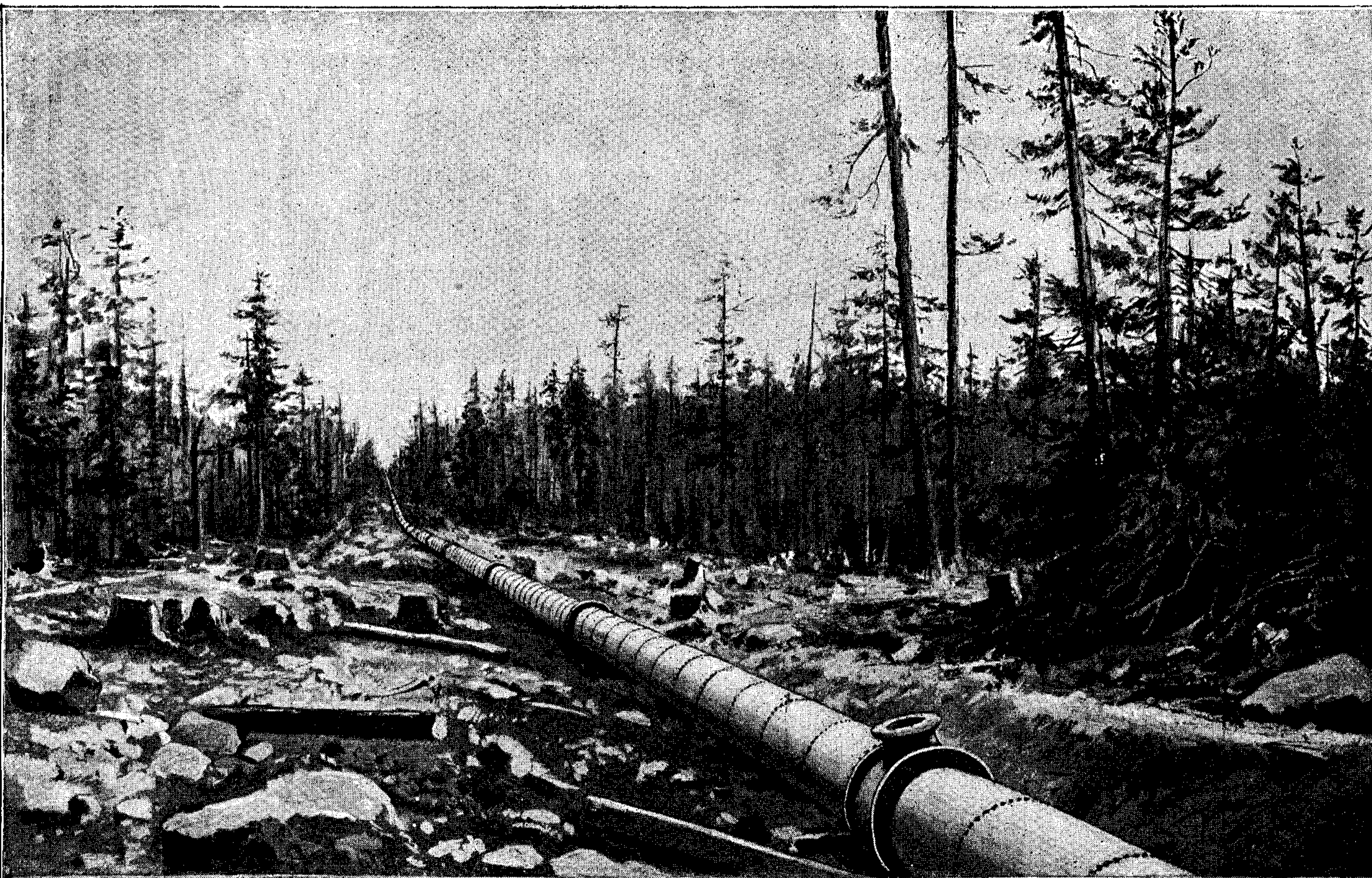
305. Труба для передачи помощью сжатого воздуха 5000 силъ, рудникъ Chapin въ Сѣверной Америкѣ,
